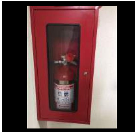
Gabinetes hechos a medida en lámina Cold Rolled, calibre 20, pintura electrostática roja y texturizada. Marco en lámina, con empaque, vidrio 3mm, chapa con 2 llaves.
